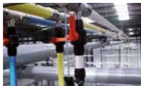
Coletores especiais e suportes de parede
